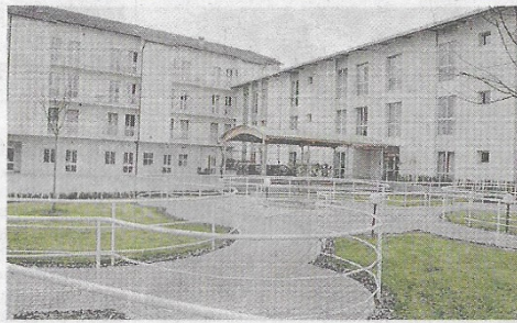
LA CASA DI RIPOSO "ELVIO PESCARMONA" DI SAN DAMIANO
